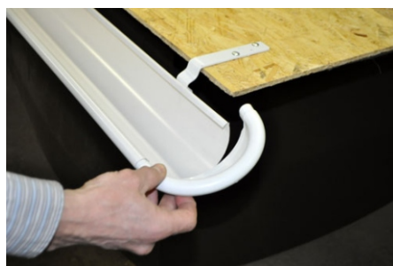
2. Вставьте завиток полукруглой заглушки в завиток желоба.
