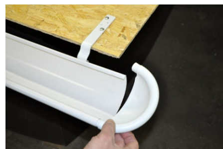
3. Проверните заглушку на себя в противоположную сторону от желоба.
