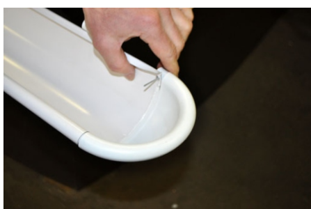
10. Установите вытяжную заклепку в отверстие.
