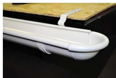
11. Удалите остатки клея в стыке желоба и заглушки.
