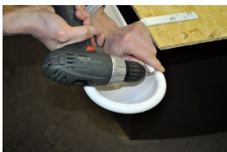
7. Просверлите отверстие под заклепку в желобе и заднем завитке заглушки.
