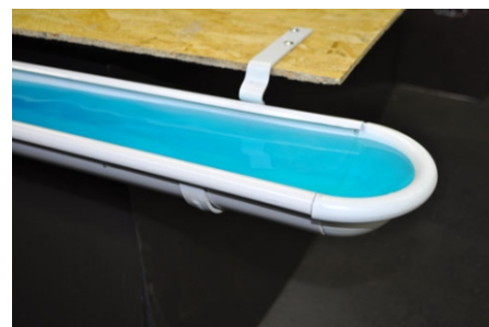
11. Удалите остатки клея в стыке желоба и заглушки.
